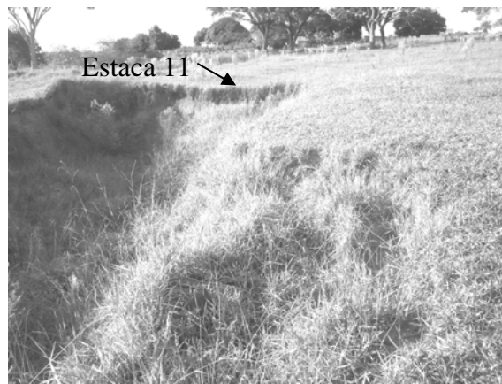
Foto 01. Expansão da ravina 03 próxima da estaca de número 11.
