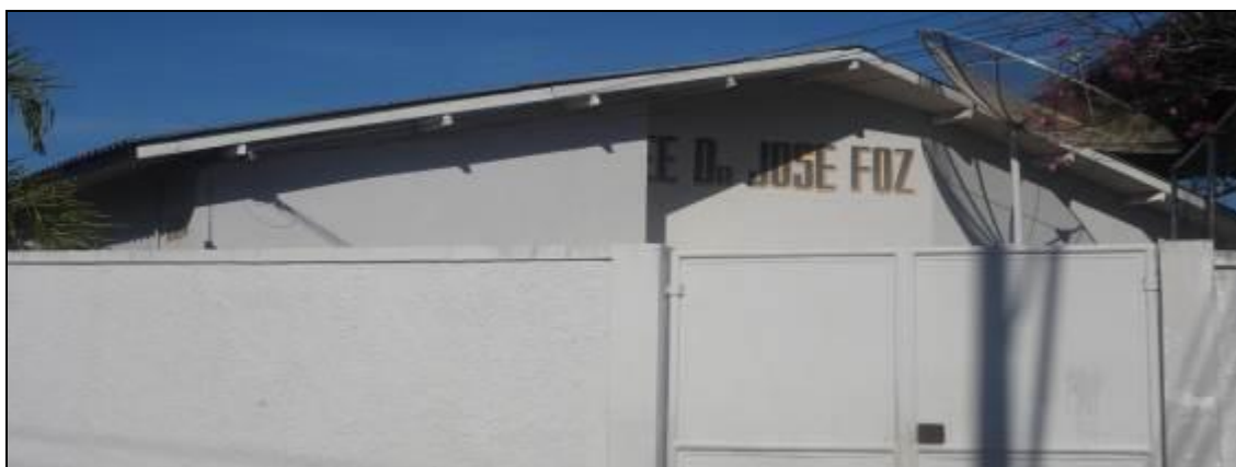
Figura 8 – Vista parcial da fachada norte da E.E.Dr. José Fóz
