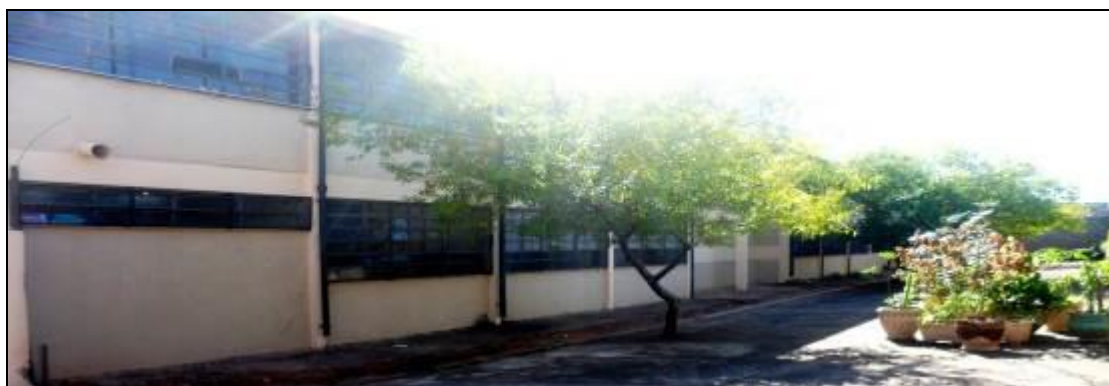
Figura 7 – Vista da fachada sudeste da E.E. Plácido Braga Nogueira
