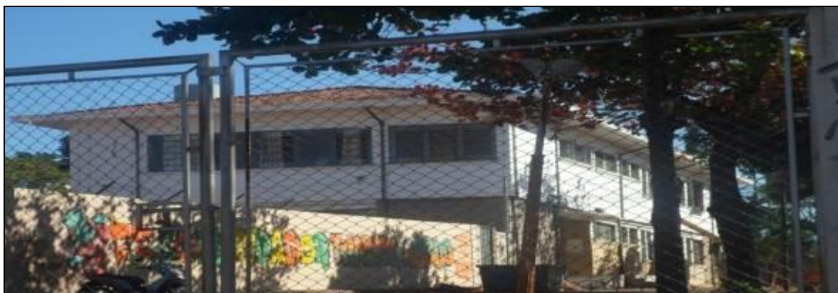
Figura 9 – Vista das fachadas sul (frente) e leste (lateral) da E.E. Comendador Tanel Abbud
