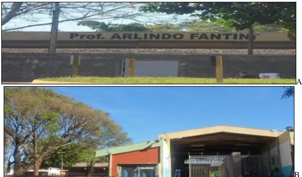
Figura 11 – Vista parcial das fachadas oeste (A) e leste (B) da E.E. Arlindo Fantini
