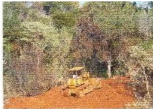
Execução de cobertura com terra – Nov. 2007
