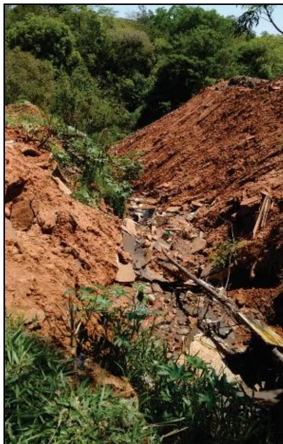
Figura 11: Deposição de materiais tecnogênicos nas proximidades do Conjunto Habitacional Augusto de Paula. Nota-se a quantidade expressiva de materiais como sedimentos, madeira e outros. Fonte: Dos autores, trabalho de campo - outubro de 2015.
