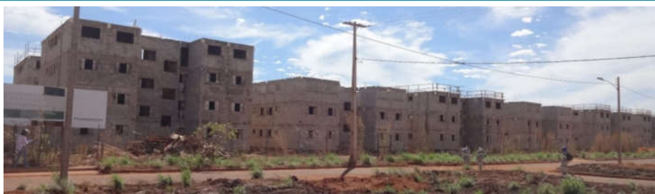
Figura 11: Palmas: edifícios do Palmas Vertical Residence North I e II, na 604 Norte. Foto: RODRIGUES (jul. 2015).
