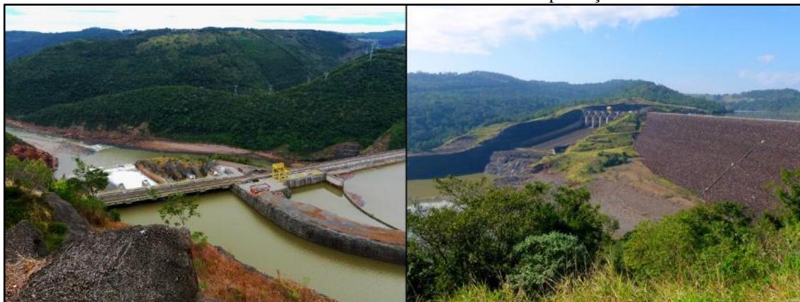
Figura 8 - Esquerda: Usina Hidrelétrica de Barra Grande. Direita: Usina Hidrelétrica de Itá. Localizadas entre os estados de Santa Catarina e do Rio Grande do Sul, representam uma grande alteração na paisagem, produzida através de modernas técnicas socionaturais e simboliza as necessidades da produção moderna urbano-industrial
