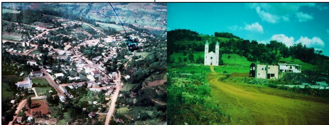
Figura 6 - Itá: início dos anos 90, antes do deslocamento da população e durante o processo de demolição das edificações existentes.
