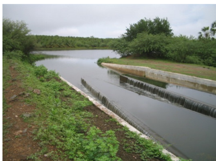
Foto 1: Derivação do canal dentro do Sítio Pintado, ao fundo são irrigados coqueiros. Fonte: Valéria R. P. de Lima. Março de 2005.
