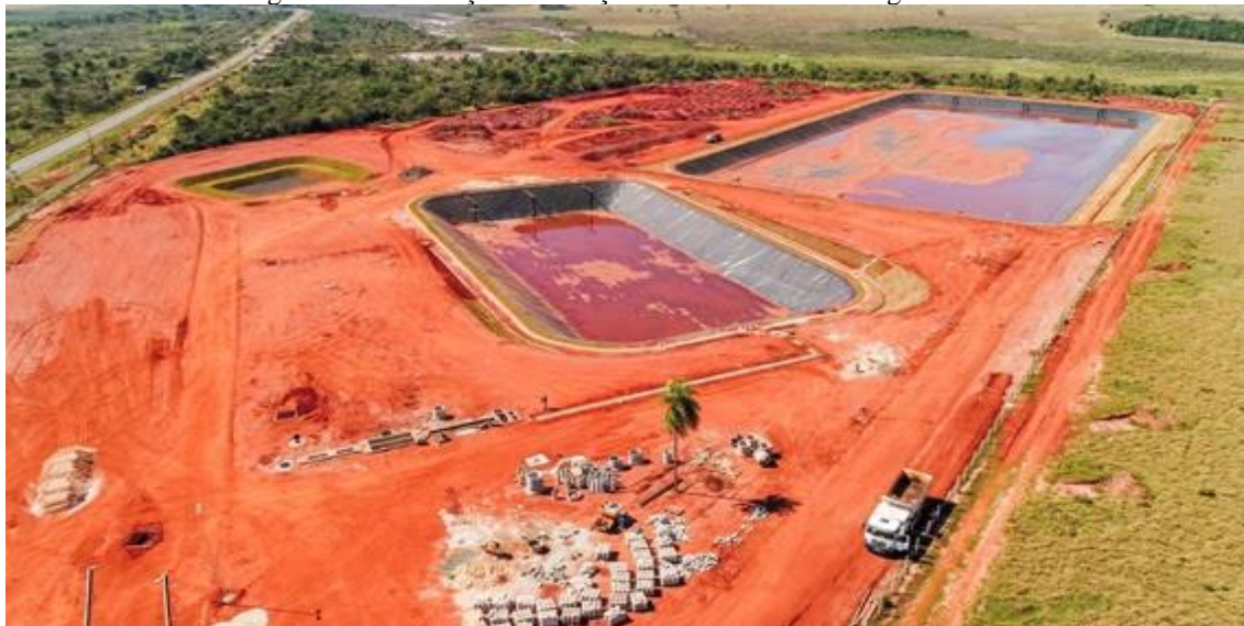
Figura 7 – Construção da Estação de Tratamento de Esgoto de Ivinhema.
