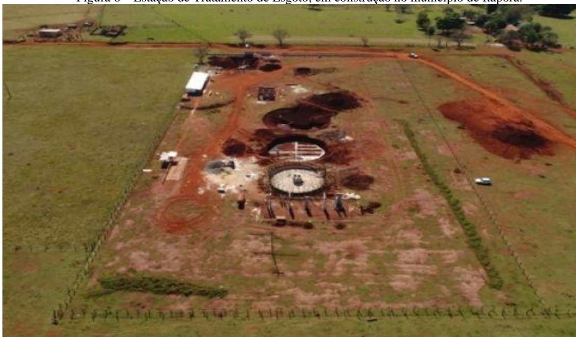
Figura 6 – Estação de Tratamento de Esgoto, em construção no município de Itaporã.
