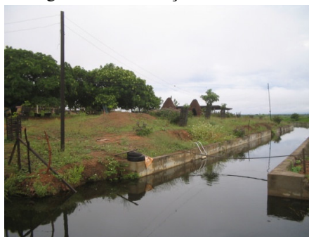
Foto 4: local onde o canal segue para a estação elevatória. Ao lado propriedade do agricultor. Fonte: Jorge Flávio Cazé. Março de 2005.
