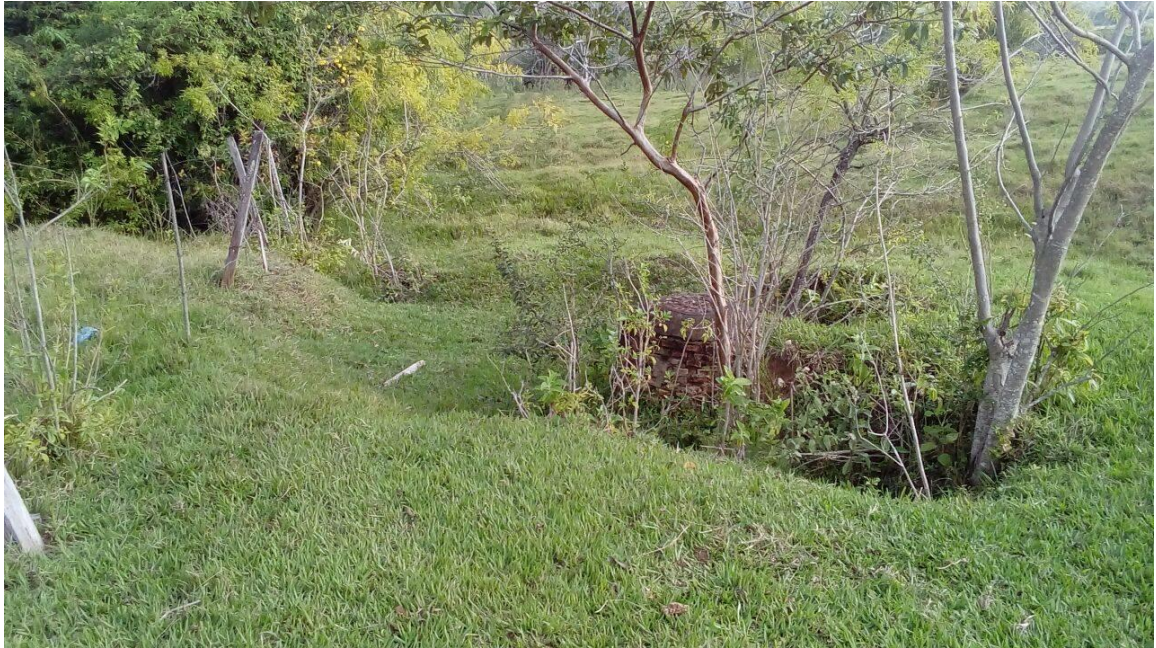
Figura 10 - Voçoroca em área rural (Fragilidade Média).
