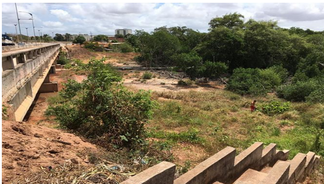
Figura 2: Aspectos da margem direita do trecho da Via Expressa, local de campo – 2017
