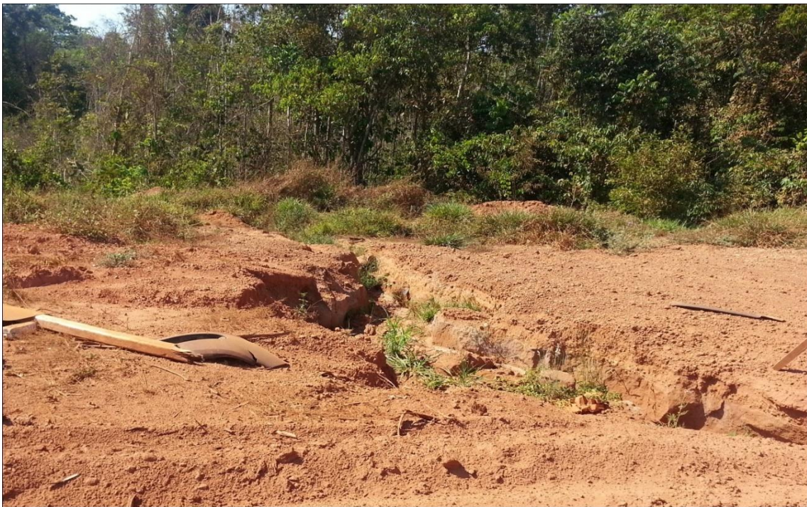
Figura 05. Processos erosivos próximos ao Rio Bonito
