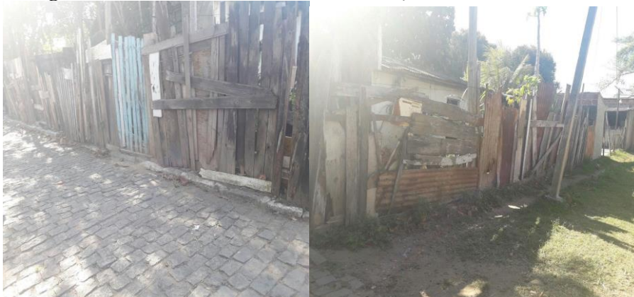
Figuras 09 e 10. Muros de madeira em habitações da favela Baleeira em 2018
