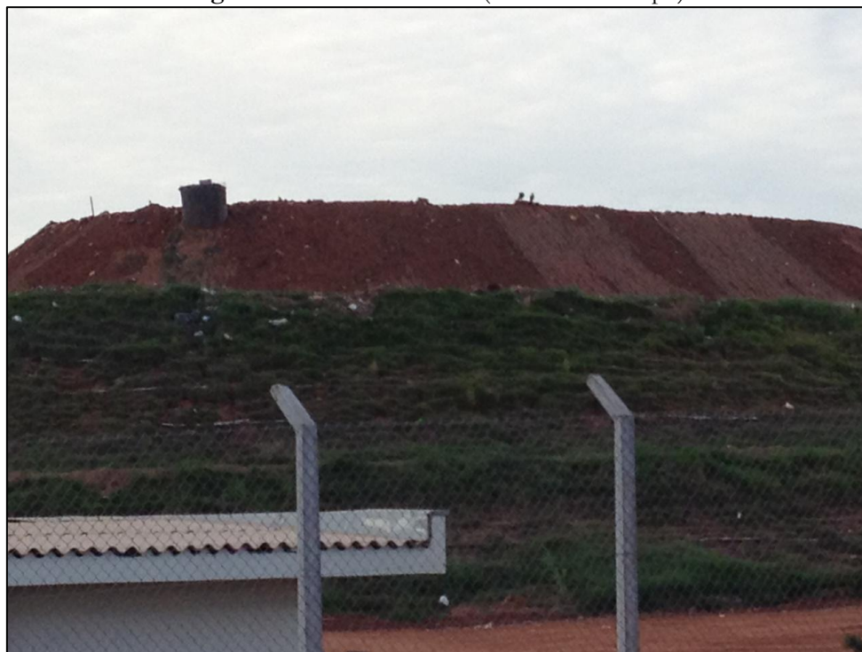
Figura 6. Aterro controlado (trabalho de campo).
