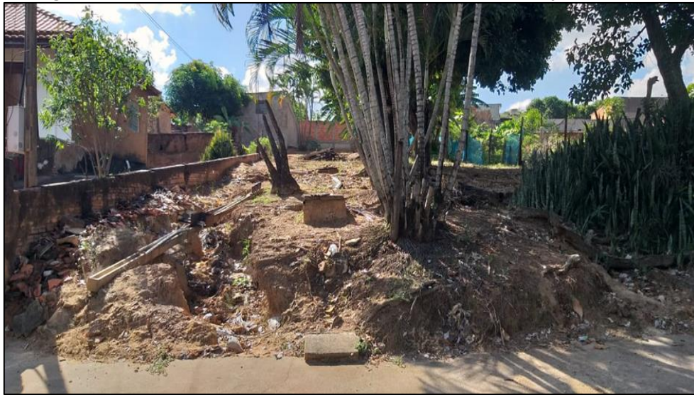
Figura 5: Formação de erosão linear entre residências no bairro Jardim Sabará.
