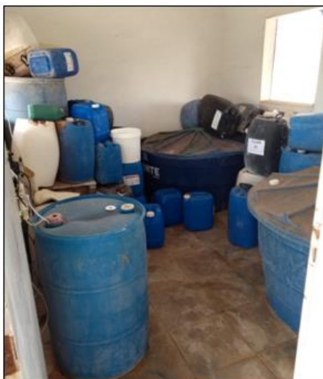
Figura 10. Pacaembu - SP. Espaço do Departamento de Água e de Esgoto (DAE) destinado ao armazenamento do cloro e do flúor. 2019.
