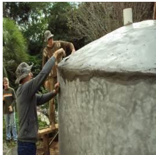
Figura 11: Fixação da massa
