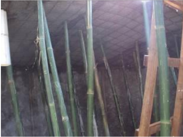
Figura 8: Bambus de apoio para fixar o topo
