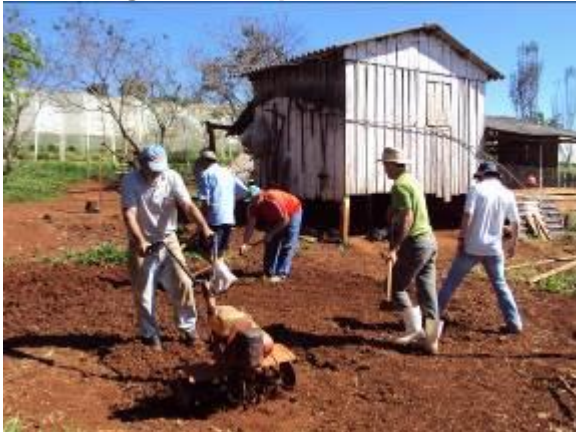
Figura 1: Preparo da base
