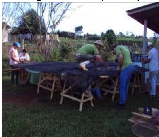
Figura 6: Construção do topo
