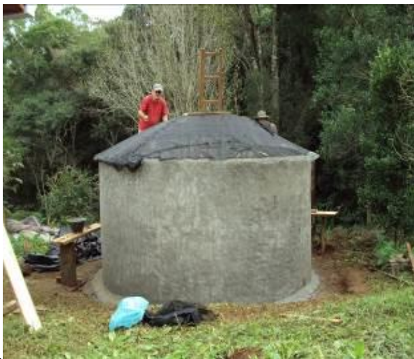
Figura 10: Topo pronto para fixação da massa
