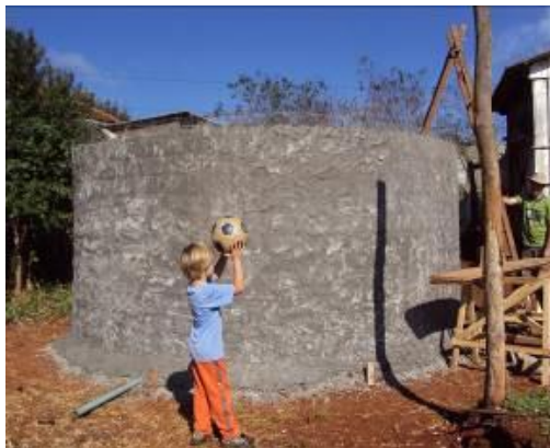
Figura 4: Parede com massa
