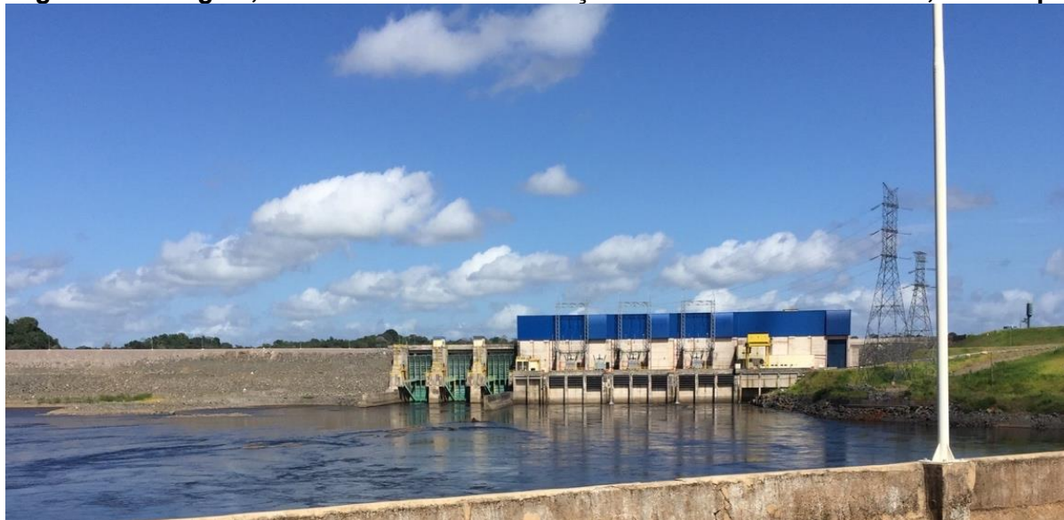
Figura 2: Barragem, vertedouro e casa de Força da UHE – Ferreira Gomes, no Amapá
