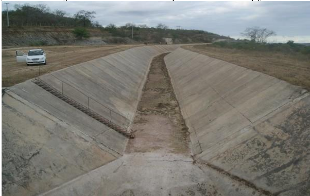
Imagem 1 - Foto das obras de construção do Canal Acauã-Araçagi
