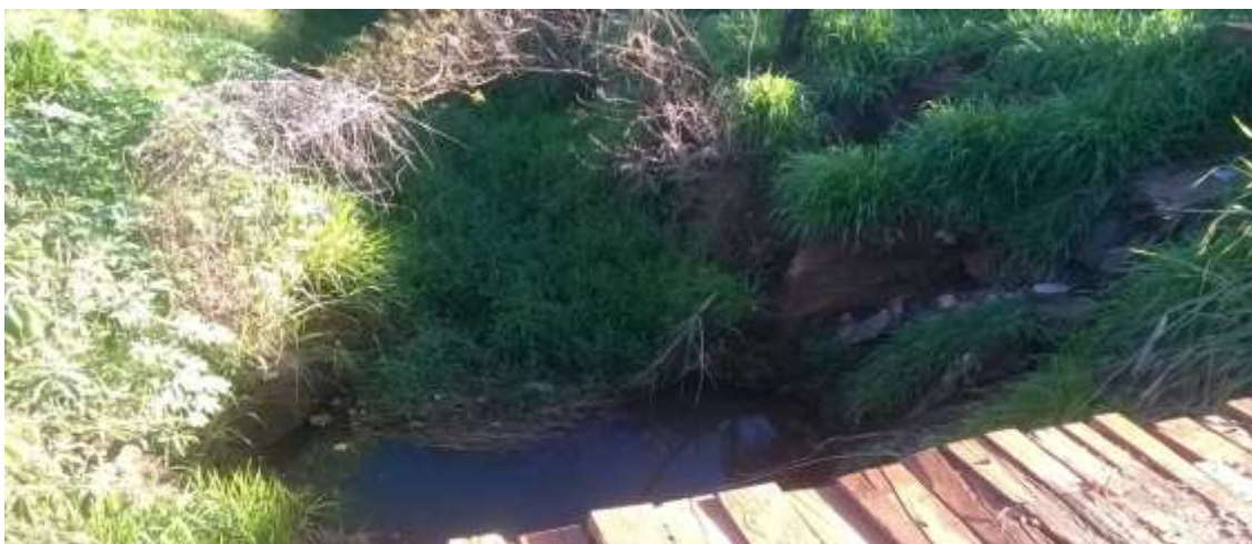
Figura2: Presença de esgoto a céu aberto no bairro de residência dos migrantes Autor:NERY, N. S. (2015)
