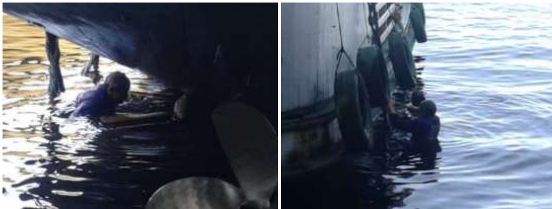
Figura 2 e 3: Amarração dos Barcos na carreira submersa
