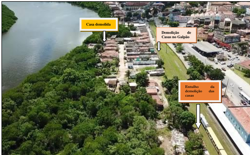
Figura 2. Vista panorâmica da área da Vila Nassau. Primeiras casas demolidas pelo Parque Ecológico Sanhauá
