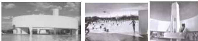
Fotos 44 a 46: Balneário Jaú, a relação interior-externo, público-privado: continuidade visual.
