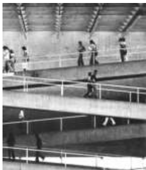
Foto 1: FAU-USP e as rampas, como espaço de vivência e circulação. Formas que identificam um lugar no edifício. A associação entre forma e conteúdo qualifica um ambiente de vivência.
