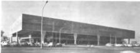
Foto 31: FAU - USP, a caixa de concreto e os sutis pontos de apoio.
