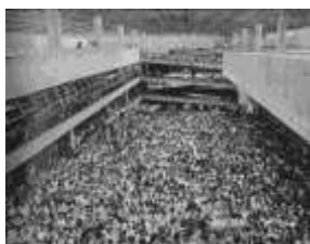
Foto 2: Assembleia dos taxistas: o Salão Caramelo e as rampas como praça cívica. O edifício como cidade.
