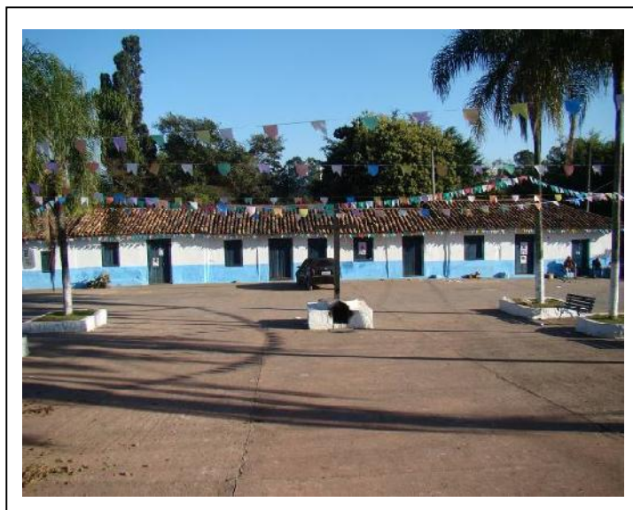
Foto 12: Área interna do pátio da Aldeia de Carapicuíba com calçamento.
