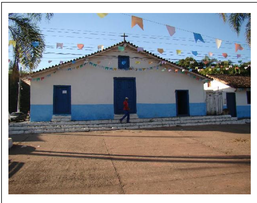
Foto 4: Capela de São João Batista. Verificam-se dos lados da Capela as passagens.
