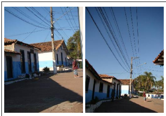
Fotos 7 e 8: Fiação da rede elétrica da Aldeia de Carapicuíba.
