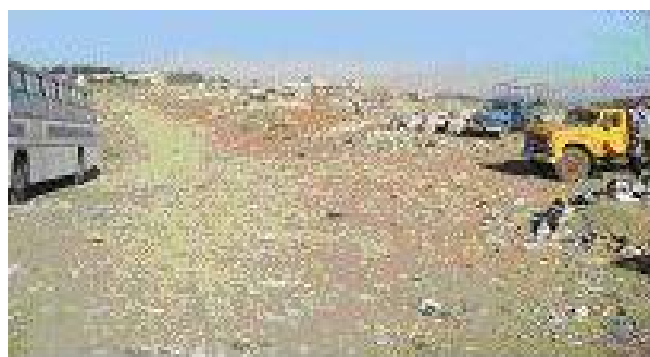
Figura 7: Aterramento para Encerramento do Lixão. Data: 29/4/2010 Autora: E. S. Martin
