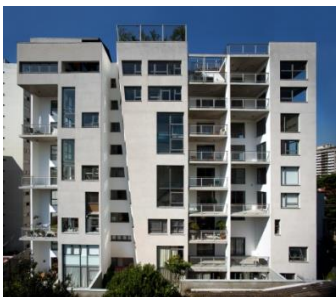
Figura 05 – Imagem do edifício Aimberê, Andrade Morettin. Os vazios constituídos por extensas varandas na elevação nordeste do edifício permitem a incidência da iluminação nos espaços internos. Fonte: http://ideazarvos.com.br , 2012.
