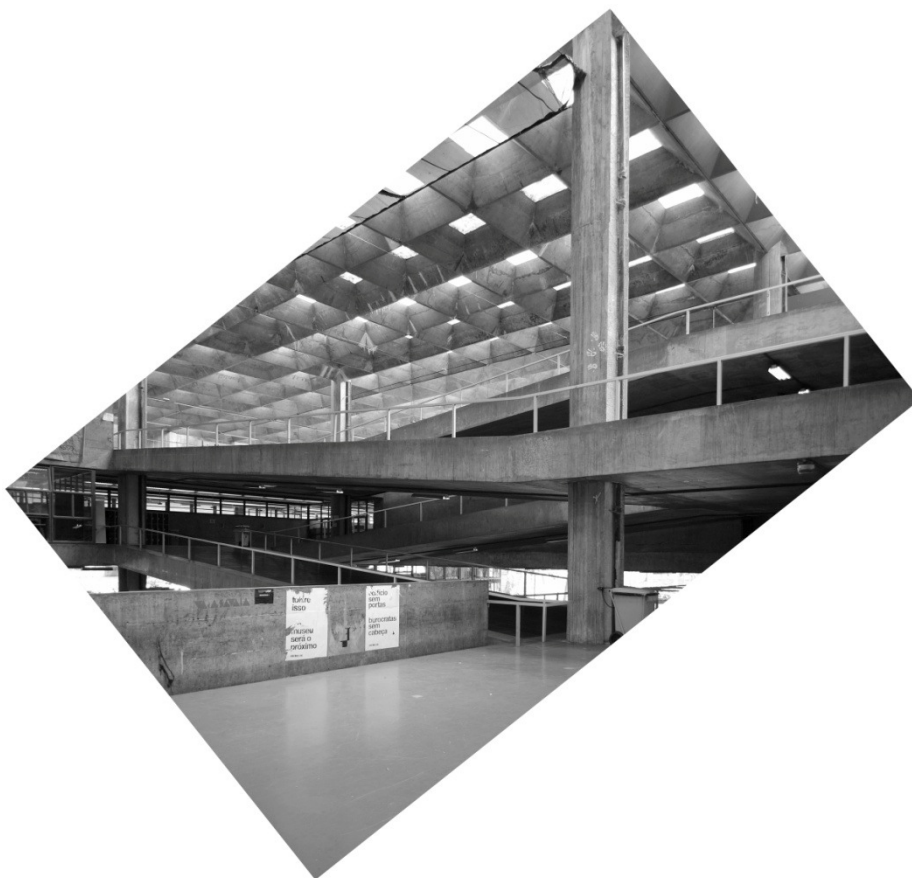
Prédio da FAUUSP em obras de restauração, Cidade Universitária, São Paulo, 2010. Projeto de Vilanova Artigas, foto de Marcos F. Gabriel.
