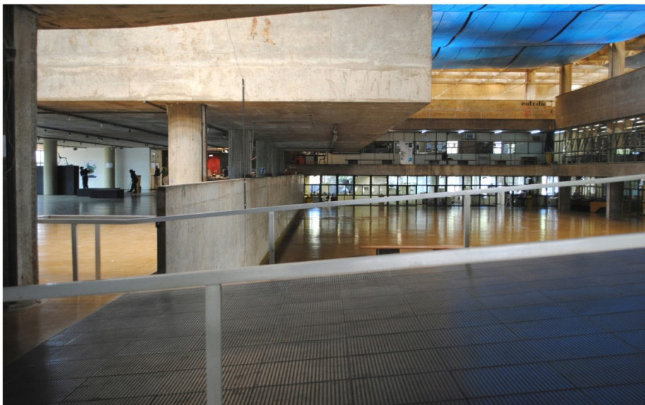
Prédio da FAUUSP em obras de restauração, Cidade Universitária, São Paulo, 2010. Projeto de Vilanova Artigas, foto de Marcos F. Gabriel.
