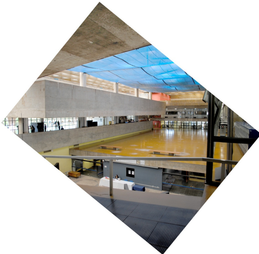
Prédio da FAUUSP em obras de restauração, Cidade Universitária, São Paulo, 2010. Projeto de Vilanova Artigas, foto de Marcos F. Gabriel.
