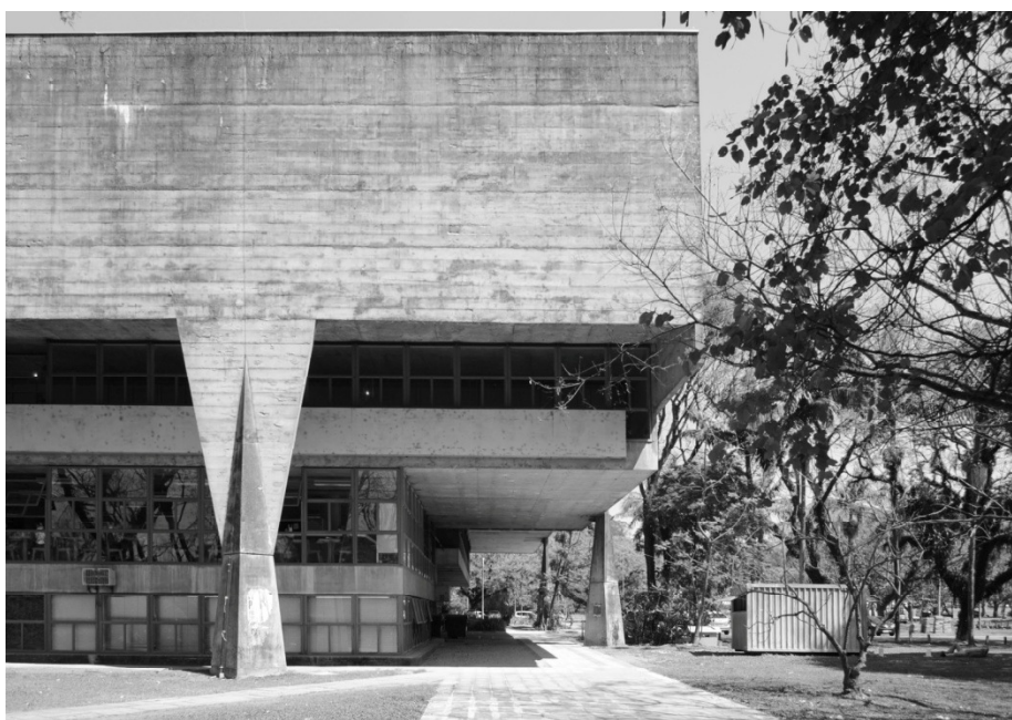
Prédio da FAUUSP em obras de restauração, Cidade Universitária, São Paulo, 2010. Projeto de Vilanova Artigas, foto de Marcos F. Gabriel.
