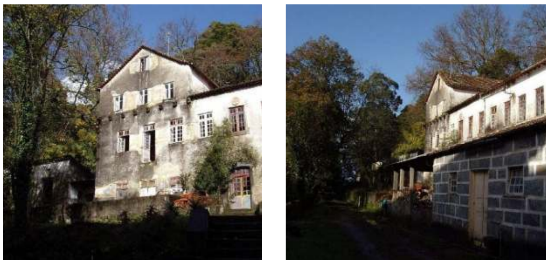
Figura 05 e 06 – “O Poverello”, 2008-2011, edifício existente.
