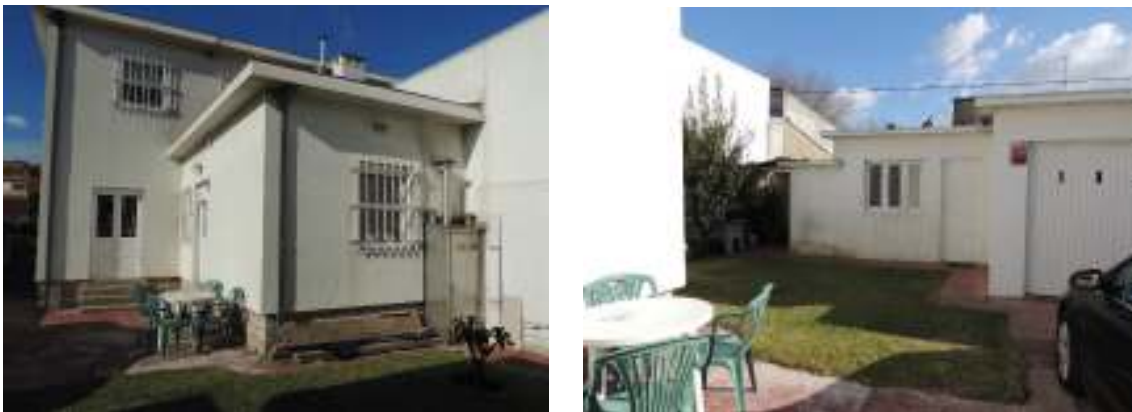
Figuras 26 e 27 – Advogados, 2012-, área de intervenção.
